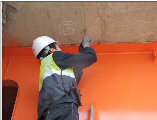
상부구조 탄산화깊이 측정
