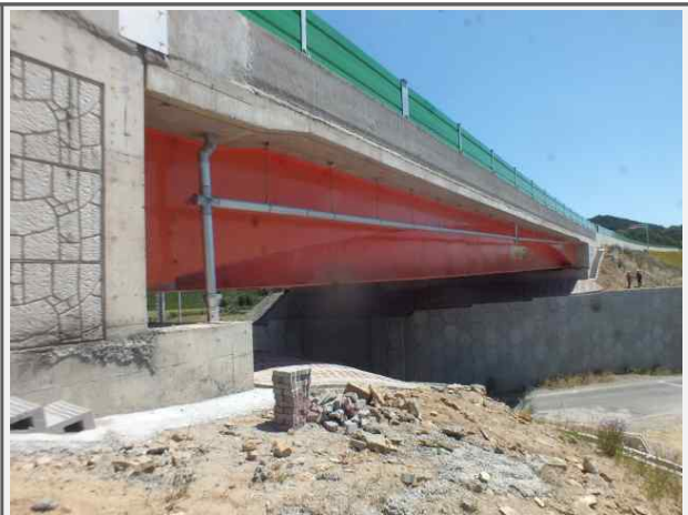
내 용 화남1교(영천) 측면
