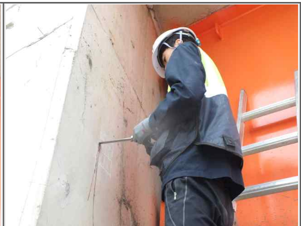
하부구조 탄산화깊이 측정
