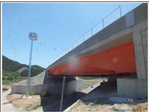
내 용 화남1교(상주) 측면
