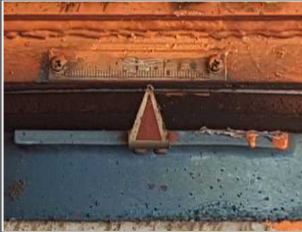
교량받침 이동량 측정
