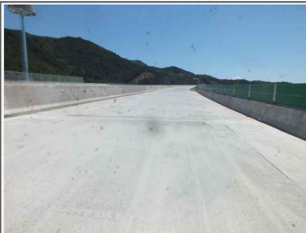
내 용 화남1교(영천) 상부
