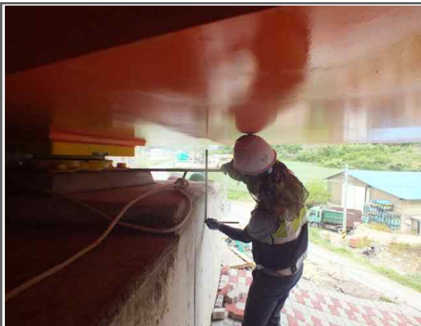
A1 연단거리 측정(상주)
