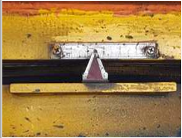
교량받침 이동량 측정
