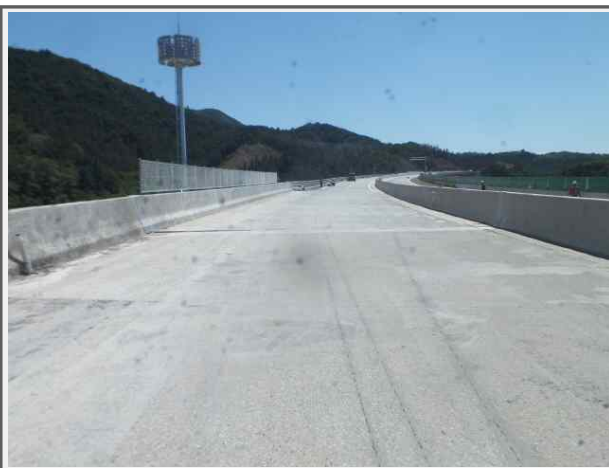
내 용 화남1교(상주) 상부
