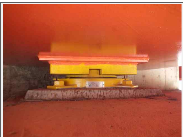
내 용 화남1교(상주) 교량받침
